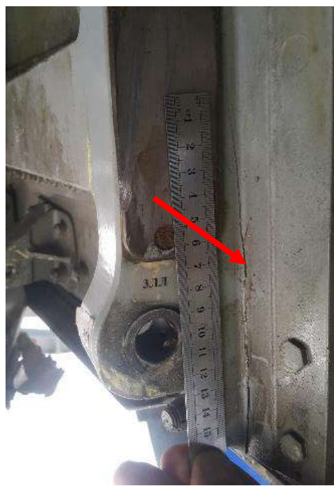
Рис. 10. Трещина в нижней части внешнего фитинга крепления узла «А» ООШ левой
