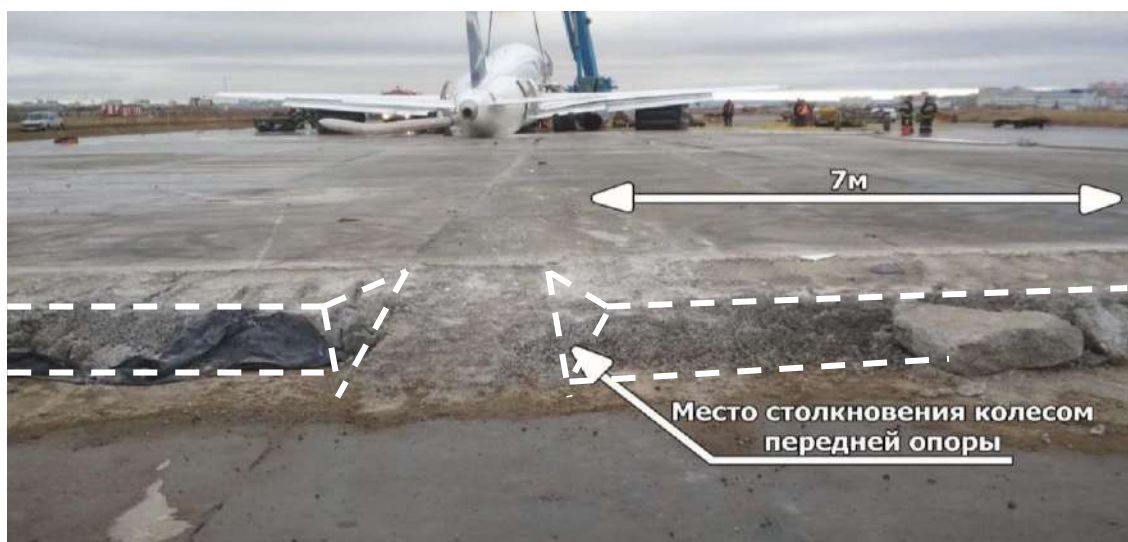
Рис. 37. Место столкновения колеса ПОШ со стыком
