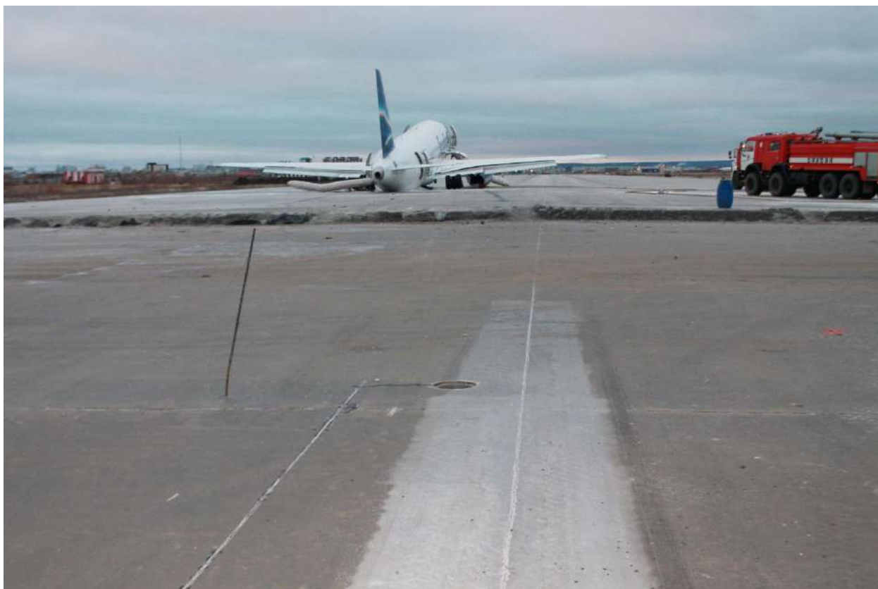
Рис. 36. Вид стыка действующей и реконструируемой частей ВПП
